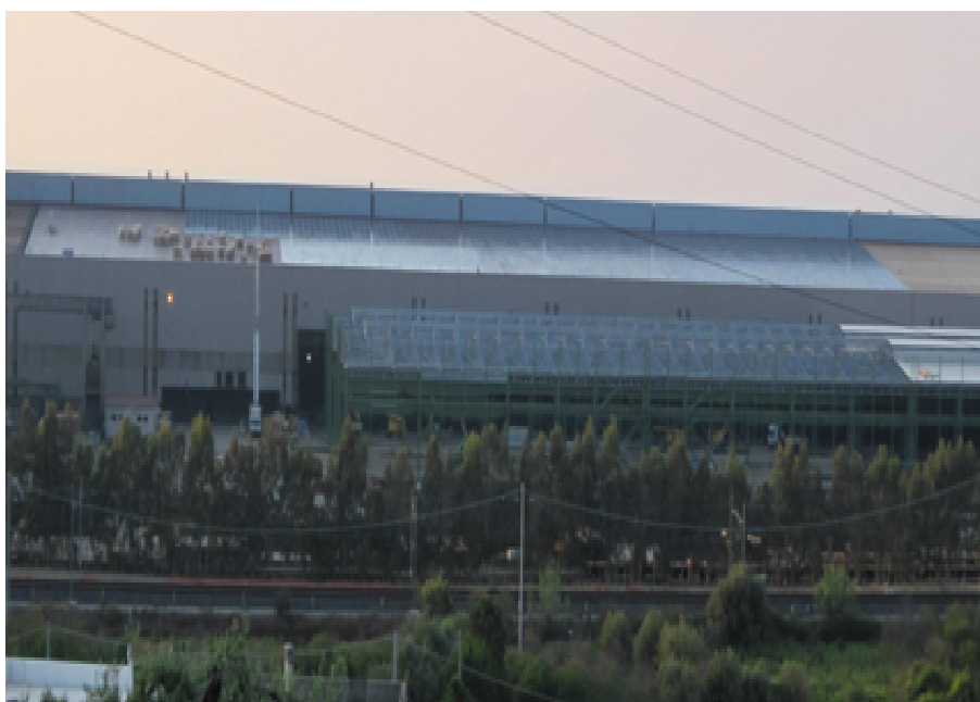
Vista generale dello stabilimento Giammoro
