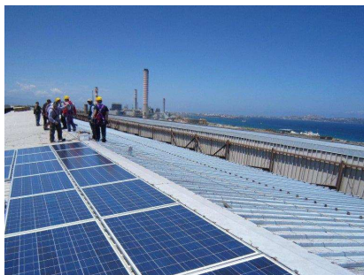
Pannelli fotovoltaici durante montaggi
