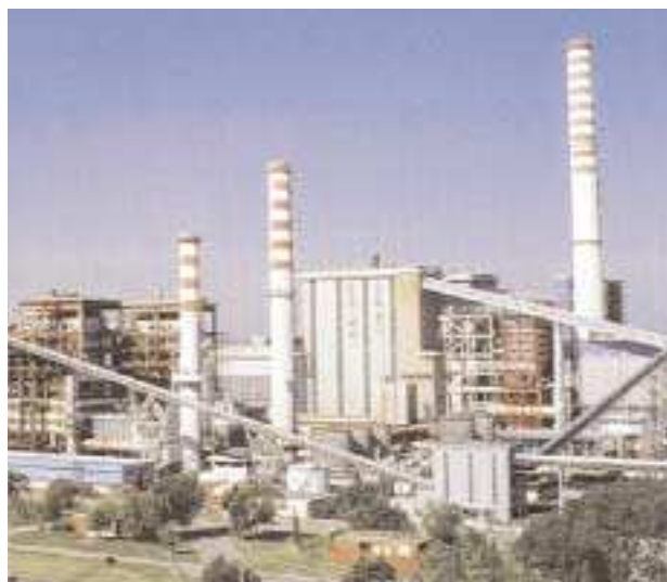
Veduta della centrale di Fusina
