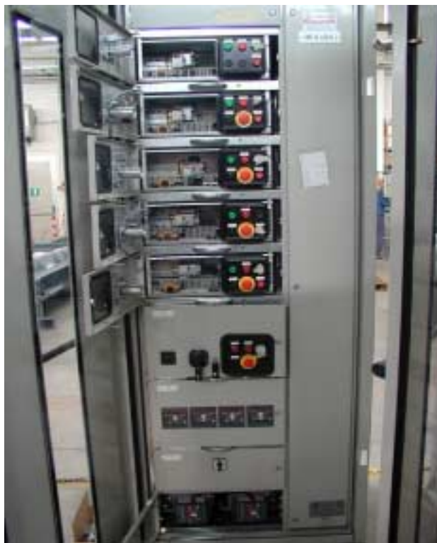
Scomparto MCC a cassette estraibili con doppia porta IP41 per unità POLIVALENTE
