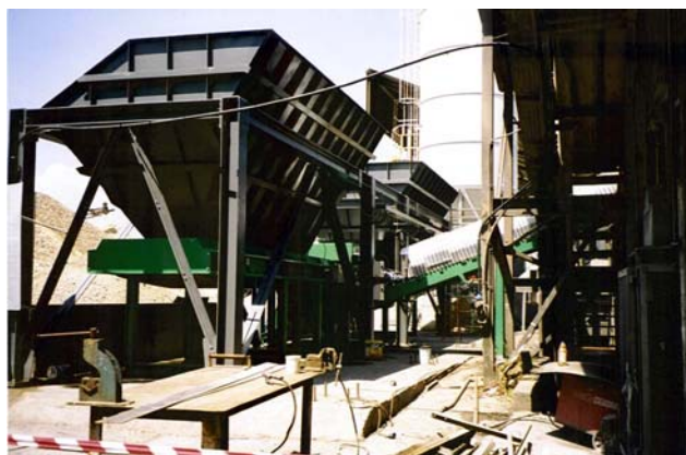
Figura 1 Montaggio tramogge di carica inerti con gli estrattori- dosatori ponderali DPL 12-60
