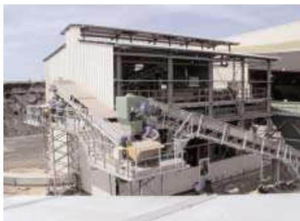
Impianto ultimato: sono visibili in primo piano i nastri che portano in quota il materiale al tripper
